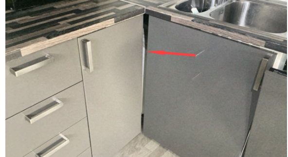
Det er ikke montert foring i hjørnet.
