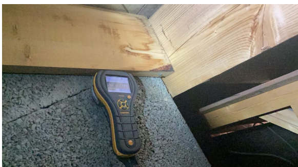
Ved enkel fuktmåling registrerte jeg tørre verdier.
