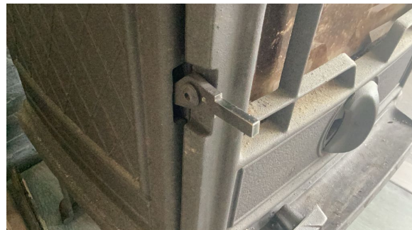
Dør til vedovn mangler del av håndtak.
