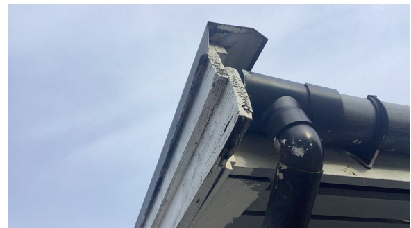
Råteskadet vindski.
