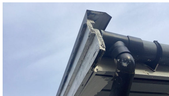
Råteskadet vindski.
