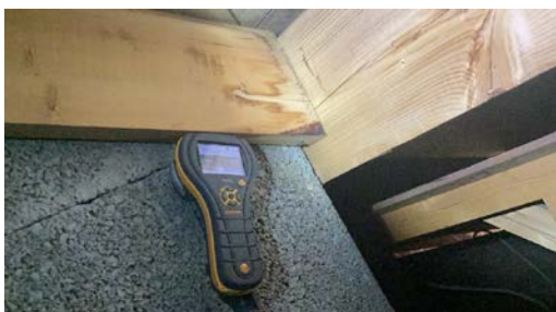
Ved enkel fuktmåling registrerte jeg tørre verdier.
