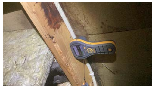
Ved enkel fuktmåling registrerte jeg tørre verdier.
