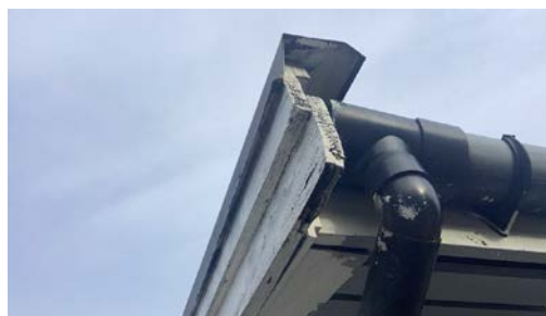
Råteskadet vindski.
