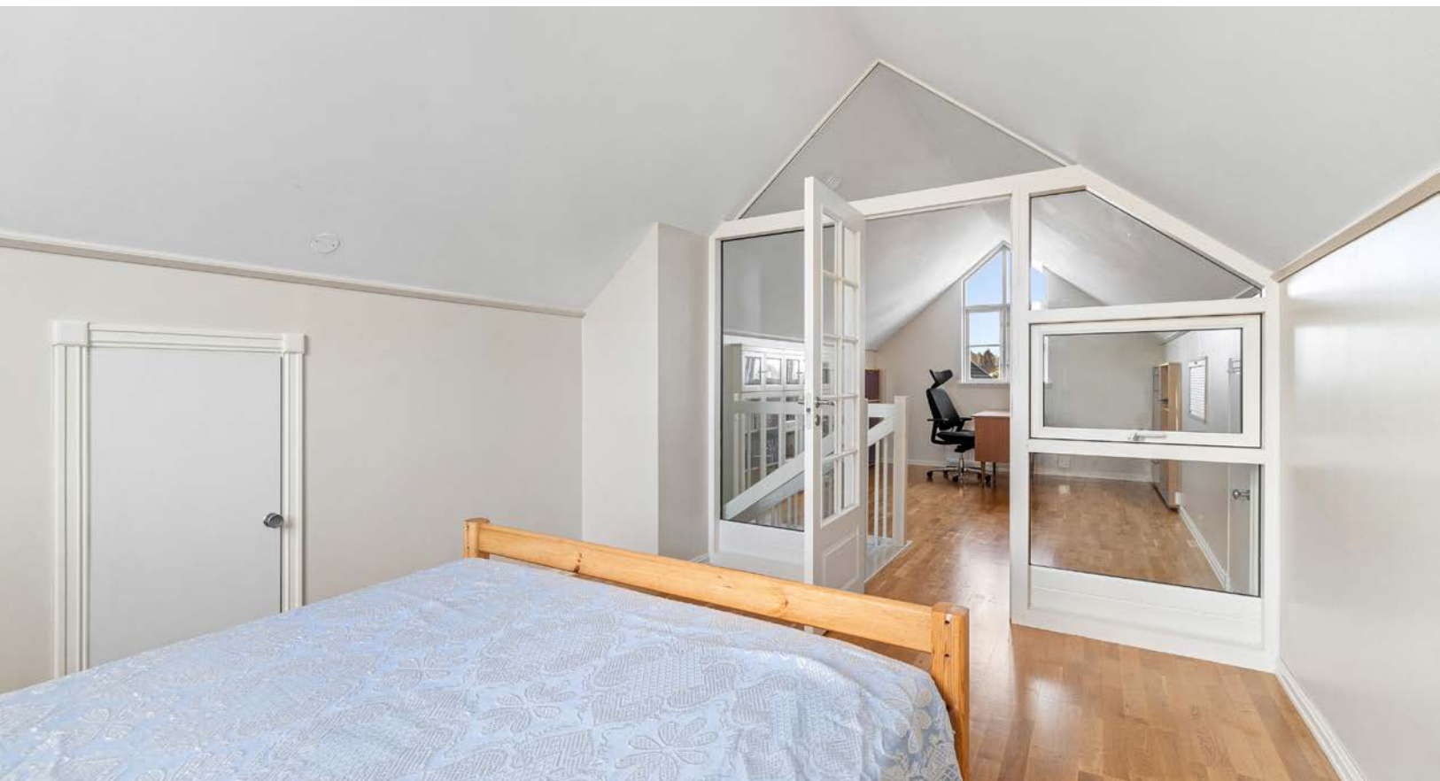
Skillevegg i glass med dør i loftsetasjen.
