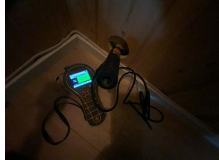
Det ble ikke målt fukt i utforet vegg på ander siden av vegg i peisstue.
