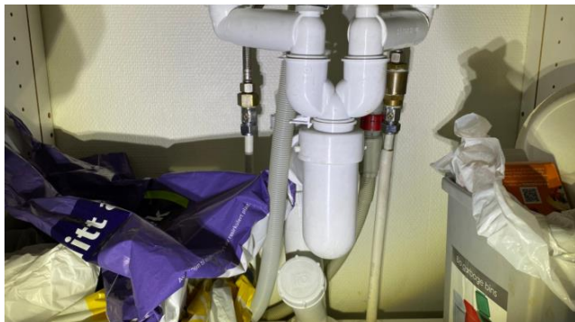
Kontroll av røropplegg.
