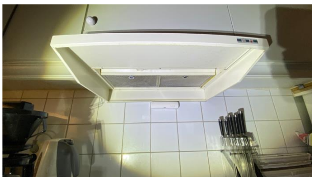
Kontroll av avtrekk.
