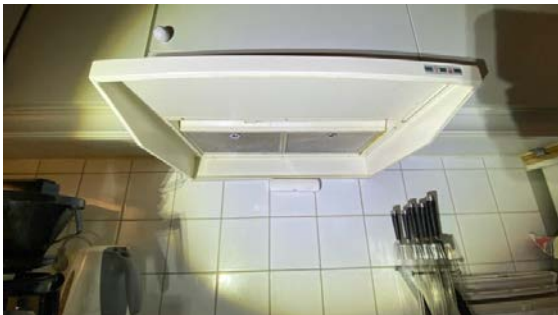
Kontroll av avtrekk.
