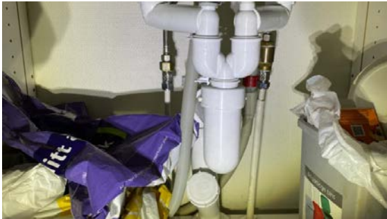
Kontroll av røropplegg.
