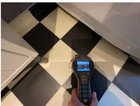
Fuktsøk er utført ved dusjkabinett, ingen forhøyde fuktavvik.
