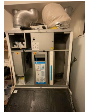
Kontrollert filter ved befaringen
