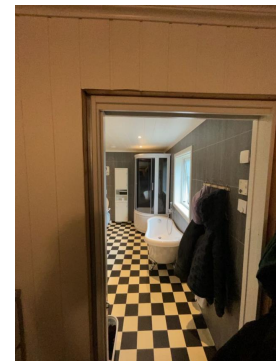
Mangler foringer og lister på skyvedør på teknisk rom
