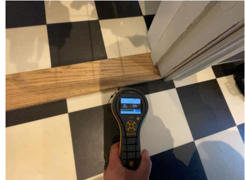
Fuktsøk er utført ved dør mot gang, ingen forhøyde fuktavvik.
