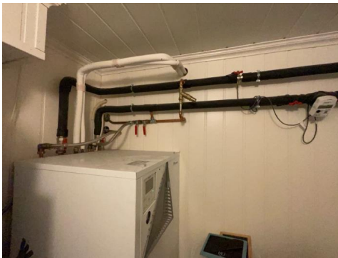
Varmtvannstank og innerdel
