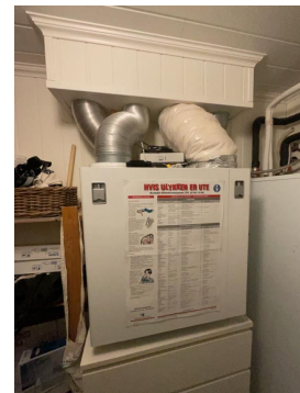
Ventilasjonsaggregat fra Flexit
