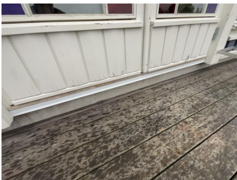
Slitasje/avskaling av maling på nedre del av verandadør
