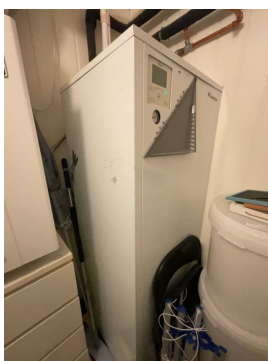
Kombinert innerdel og varmtvannstank
