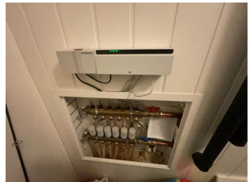
Fordelerskap gulvvarme
