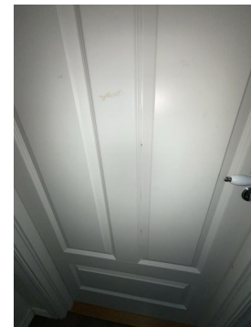
Skade i foliering på dør ved speil på dør til soverom 5
