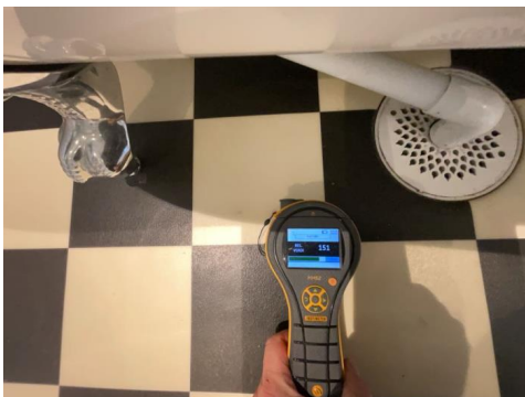
Fuktsøk er utført ved sluk under badekar, ingen forhøyde fuktavvik.
