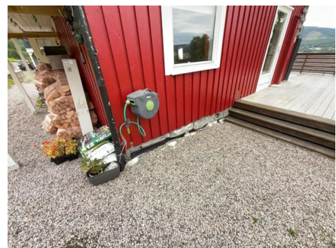
Sprekker i mur på gavelvegg
