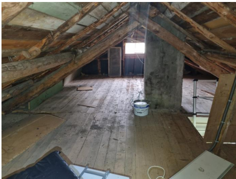
Ingen synlig etablert lufting i raftekasser ved overgang tak/vegg
