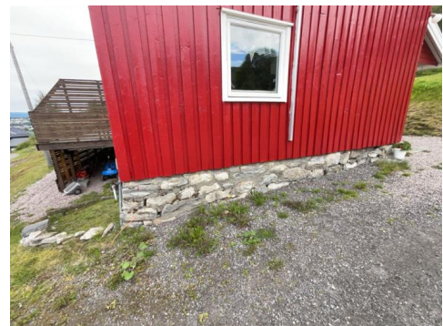
Sprekker i mur på gavelvegg
