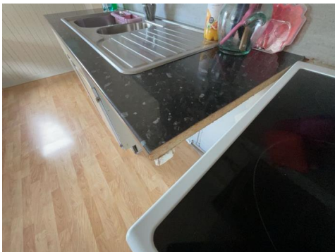
Mangler kantlist på benkeplate ved komfyr
