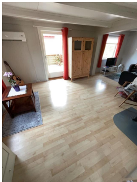
Gulv på stue er slitt/svelleskader i skjøter på laminatgulv
