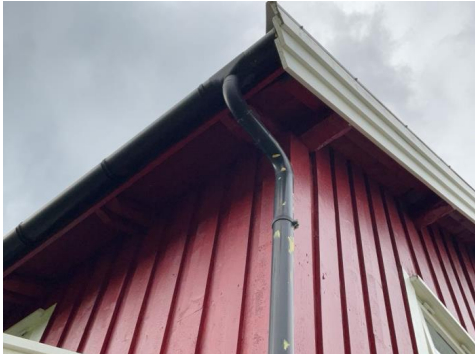
Ingen synlig etablert lufting i raftekasser ved overgang tak/vegg
