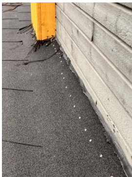
Overgang takteking og yttervegg er ikke fagmessig utført.
