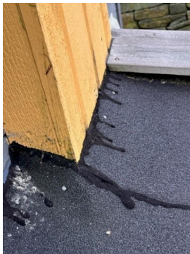
Overgang takteking og yttervegg er ikke fagmessig utført.
