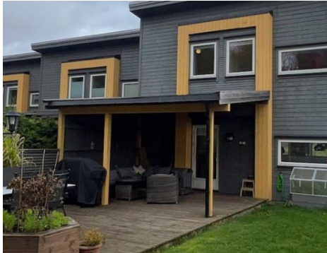
Takoverbygg til terrasse.
