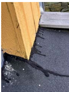
Overgang taktekkning og yttervegg er ikke fagmessig utført.
