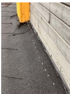
Overgang taktekkning og yttervegg er ikke fagmessig utført.
