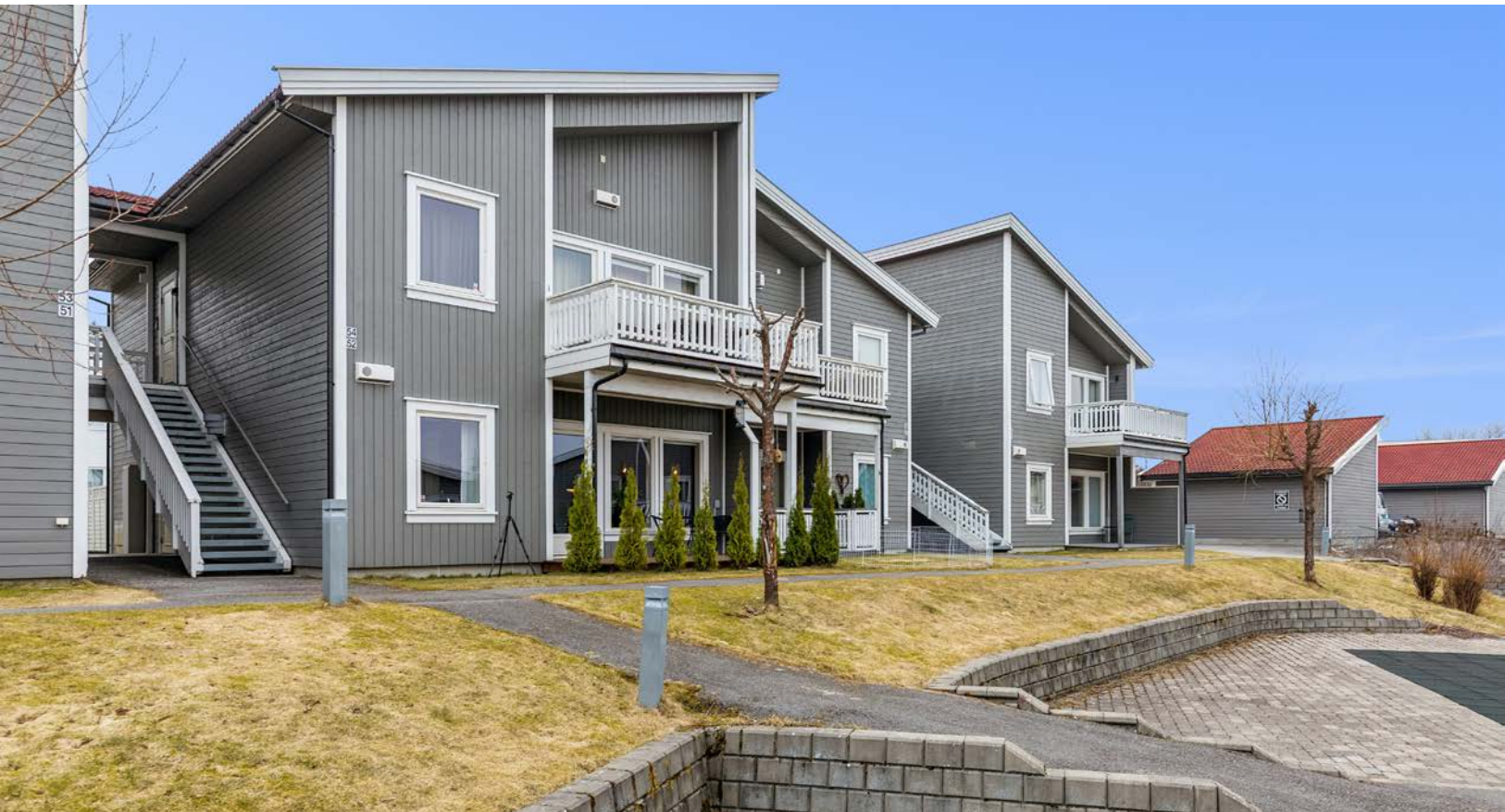
Pent opparbeidet fellesområde med asfalterte gangstier, støttemurer og belysning.
