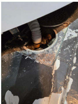
Bildet viser gammel sluk og sprukne fliser
