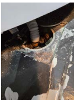
Bildet viser gammel sluk og sprukne fliser
