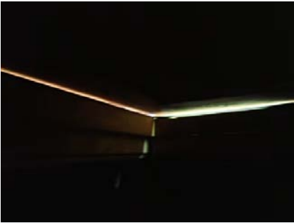
Utettheter/skjevheter mellom karm og dørblad.
