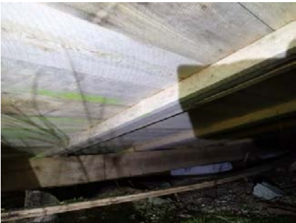
Oversiktsbilde under boligen.
