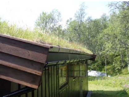
Tydelige svanker ved takfoten.
