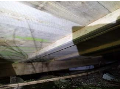
Oversiktsbilde under boligen.
