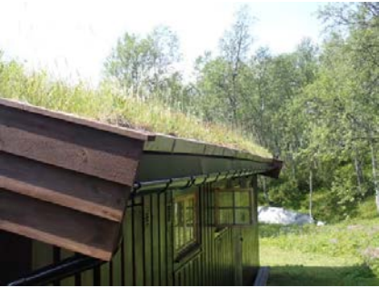
Tydelige svanker ved takfoten.
