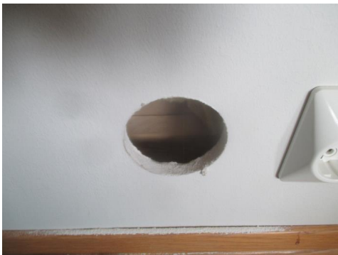
Hulltaking i fra loftstue.
