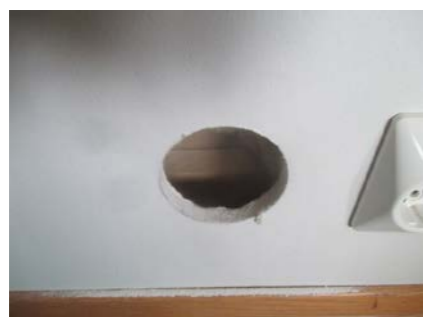
Hulltaking i fra loftstue.
