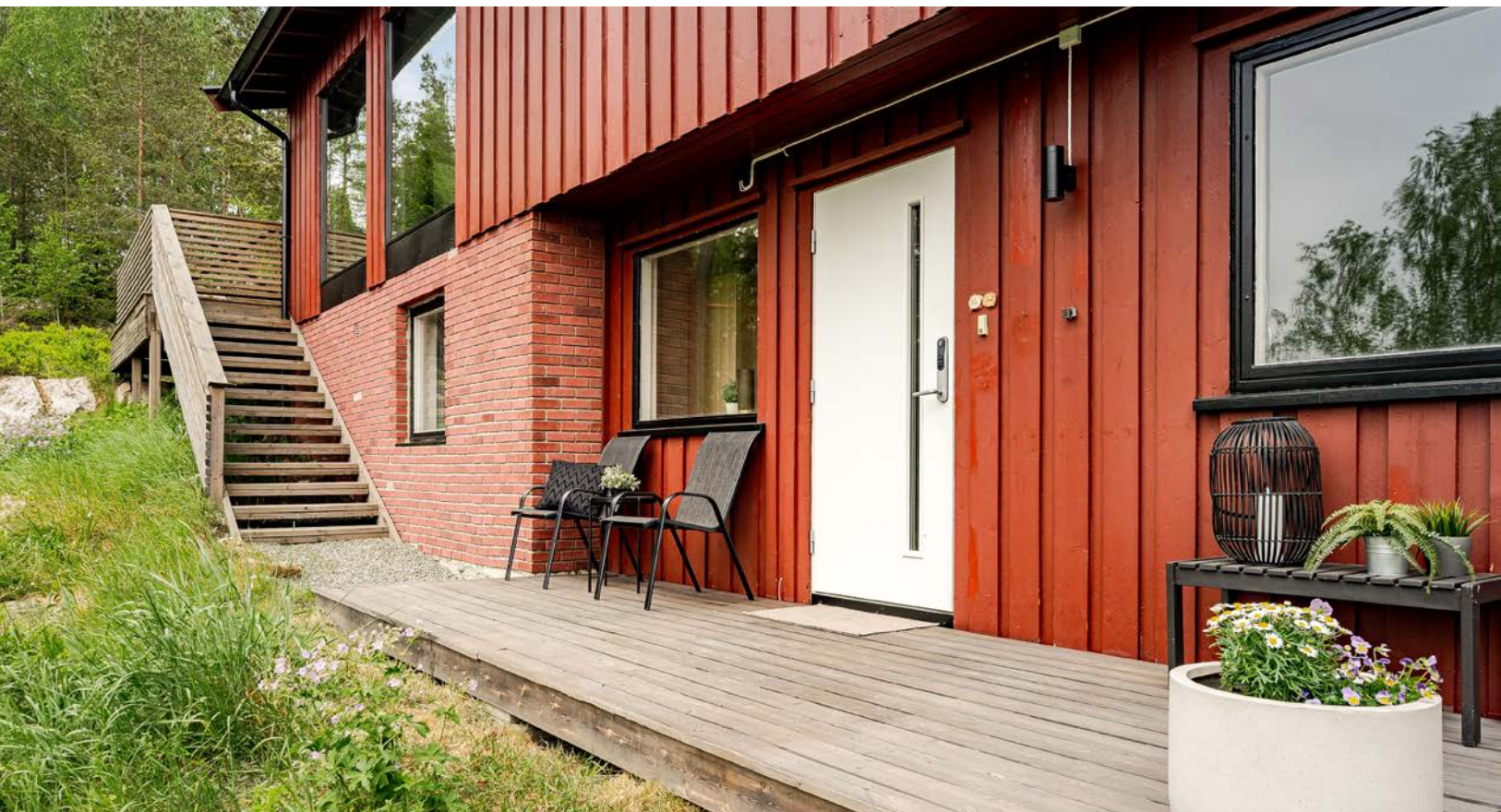
Bygget ny terrasse ved inngangspartiet i 2020. Beliggenheten mot syd sørget for gode solforhold. Praktisk med kodelås montert på ytterdøren.
