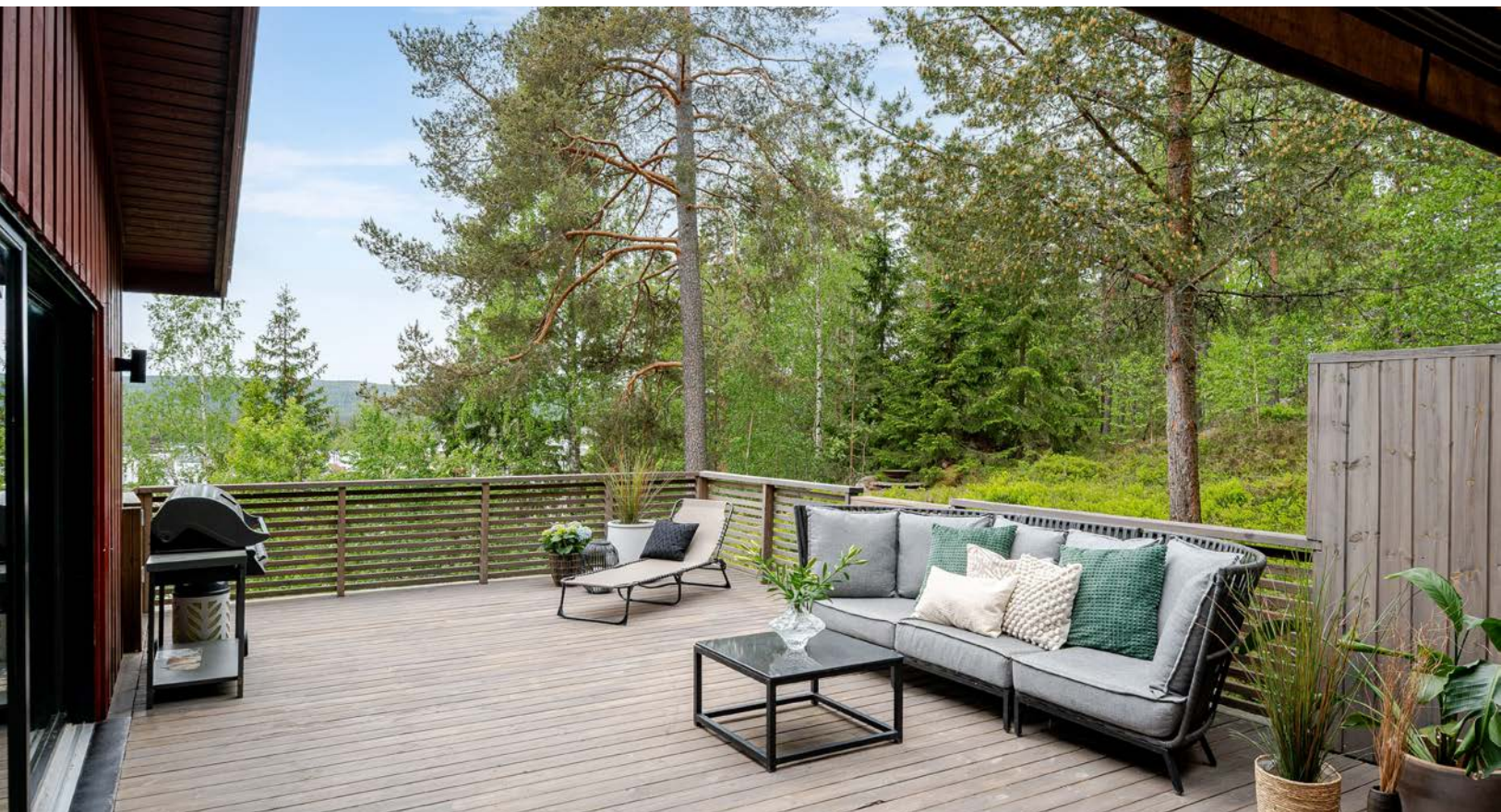
Terrassen har terrassebord på gulv og rekkverk av liggende trespiler. Det er også montert markise, utebelysning og stikkontakt.
