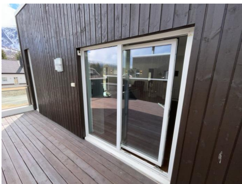
Terrasse over garasje
