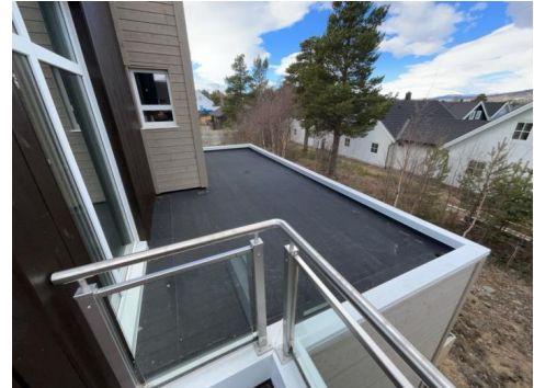
Synlig del av takkonstruksjonen.
