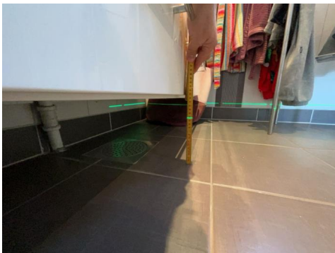
Målt inntil sluk under servant
