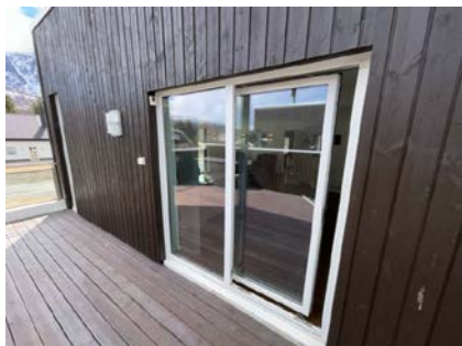
Terrasse over garasje
