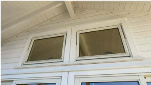
Eksempel på vindu i yttervegg.
