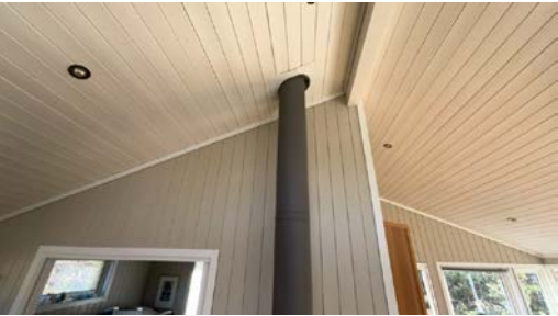
Del av pipe.
