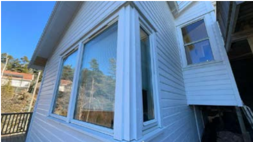
Eksempel på vindu i yttervegg.
