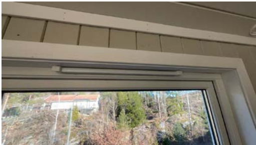
Eksempel på montert ventil i vindu.
