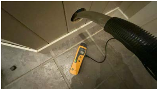
Hull for kontroll av fukt.
