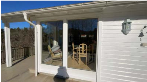
Eksempel på vindu i yttervegg.
