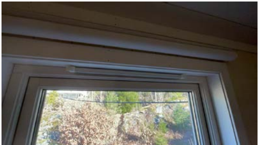
Eksempel på montert ventil i vindu.
