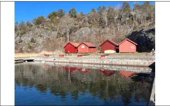
Del av felles bryggeanlegg.
