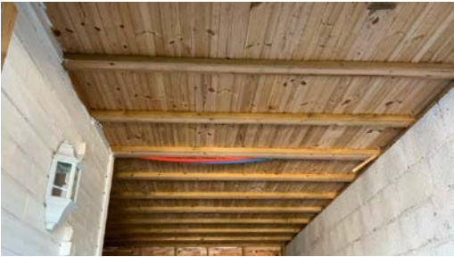
Del av etasjeskille sett fra undersiden.
