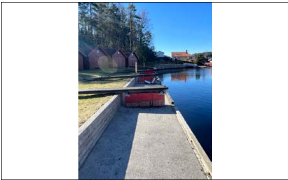
Del av felles bryggeanlegg.
