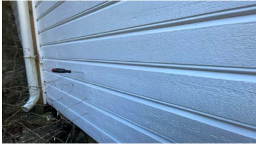
Stikk kontroll av vegger er utført.
