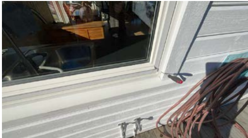
Stikkontroll på vinduer er utført.
