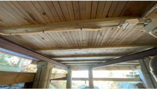
Del av etasjeskille sett fra undersiden.
