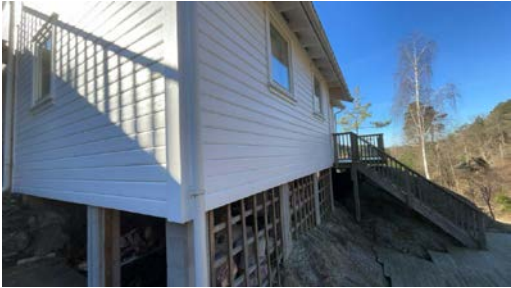
Del av vegg.
