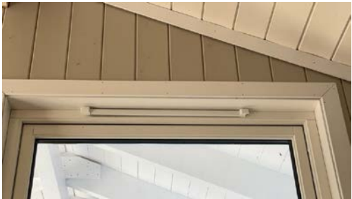
Eksempel på montert ventil i vindu.
