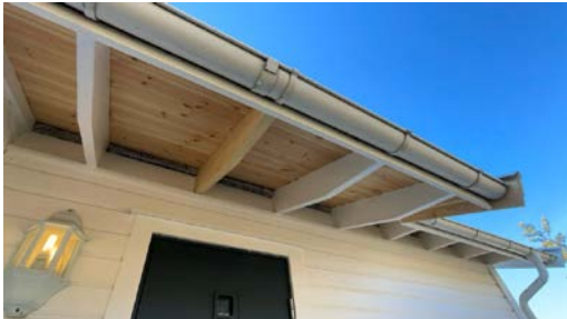
Konstruksjon sett fra terrasse.
