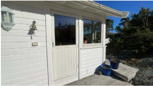
Terrassedør inn til kjøkken.
