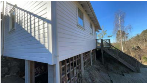
Del av vegg.
