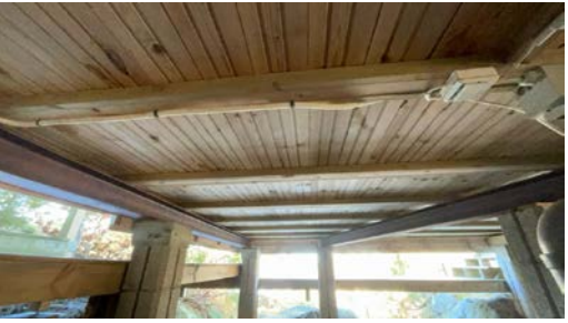
Del av etasjeskille sett fra undersiden.
