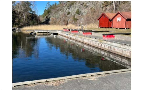
Del av felles bryggeanlegg.
