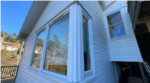
Eksempel på vindu i yttervegg.
