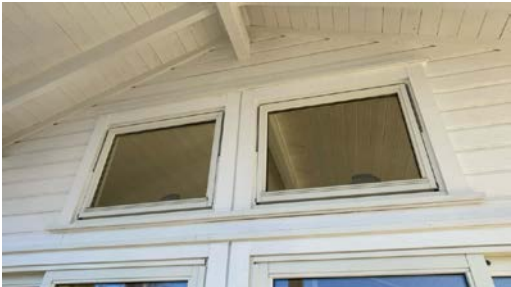
Eksempel på vindu i yttervegg.
