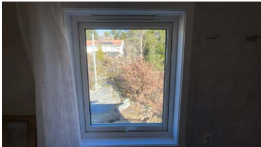
Rommet har kun naturlig ventilasjon. Vindu med ventil.
