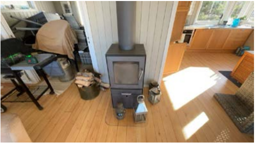
Montert ovn i stue.
