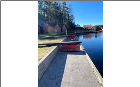
Del av felles bryggeanlegg.
