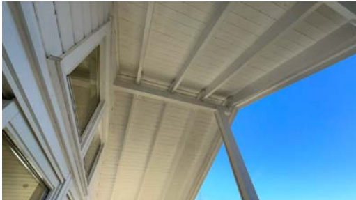
Konstruksjon sett fra terrasse.
