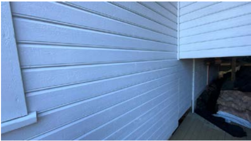
Del av vegg.
