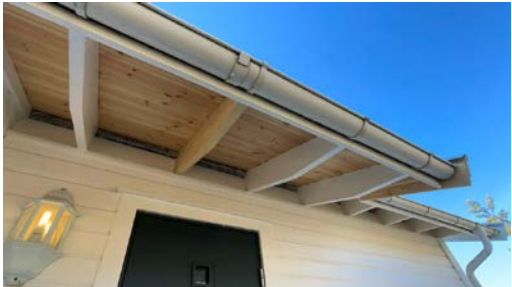
Konstruksjon sett fra terrasse.
