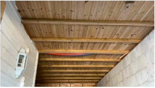
Del av etasjeskille sett fra undersiden.
