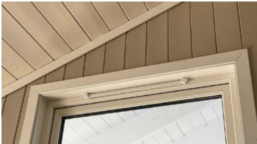
Eksempel på montert ventil i vindu.
