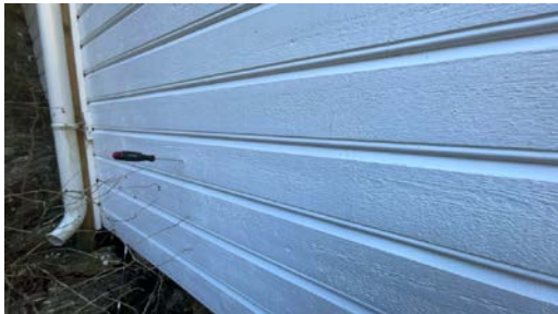
Stikk kontroll av vegger er utført.
