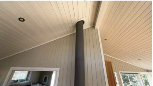
Del av pipe.
