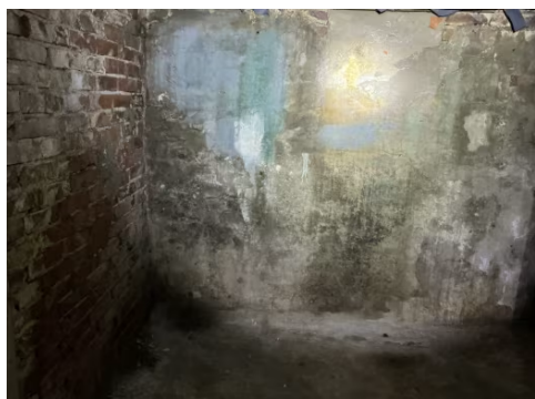
Synlig fukt-gjennomtrening i yttervegger.
