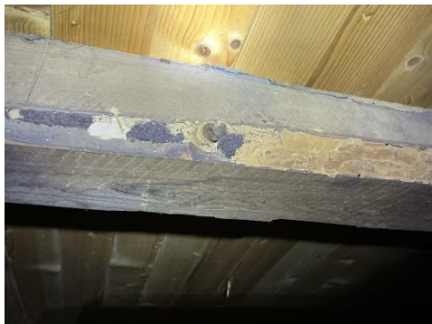
Flyve-hull etter borebille/morr i konstruksjoner.
