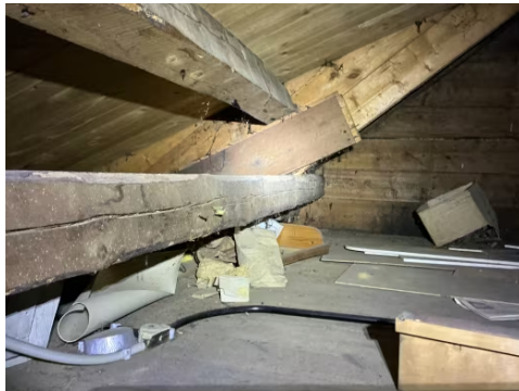
Flyve-hull etter borebille/morr i konstruksjoner.
