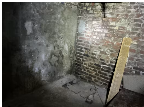
Synlig fukt-gjennomtrening i yttervegger.
