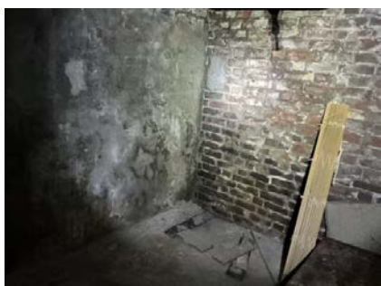
Synlig fukt-gjennomtrening i yttervegger.
