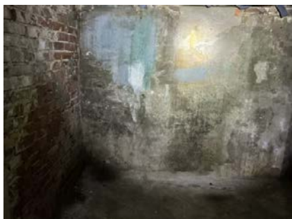
Synlig fukt-gjennomtrening i yttervegger.
