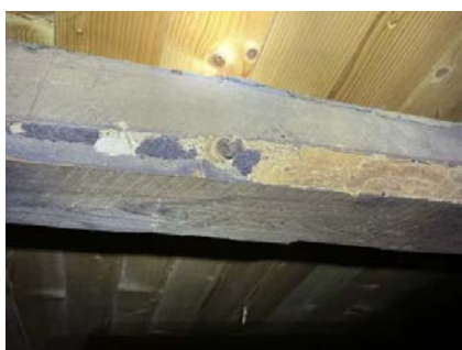
Flyve-hull etter borebille/morr i konstruksjoner.
