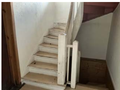
Trapp til inngang har stor avstand mellom trinn.
