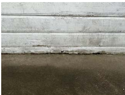
Det er ikke lufting mellom kledning og balkong. Fukt/råteskade på kledning TG 3.
