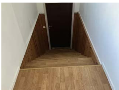
Trapp til inngang har stor avstand mellom trinn.
