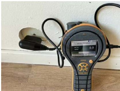
Innervegger med plank.
