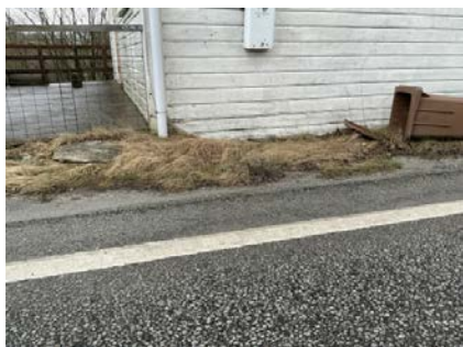
Terreng har fall fra gate/hovedvei mot bolig.
