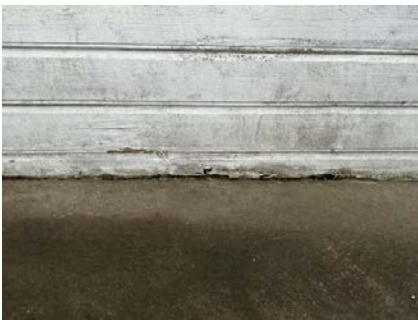
Det er ikke lufting mellom kledning og balkong. Fukt/råteskade på kledning TG 3.
