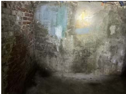
Synlig fukt-gjennomtrening i yttervegger.
