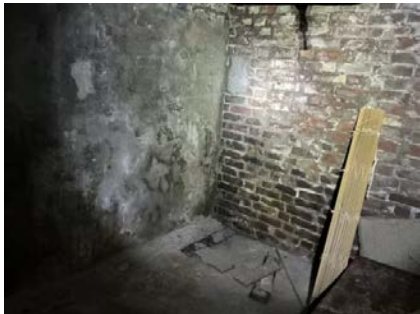
Synlig fukt-gjennomtrening i yttervegger.
