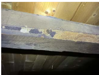
Flyve-hull etter borebille/morr i konstruksjoner.
