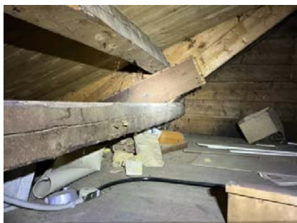
Flyve-hull etter borebille/morr i konstruksjoner.
