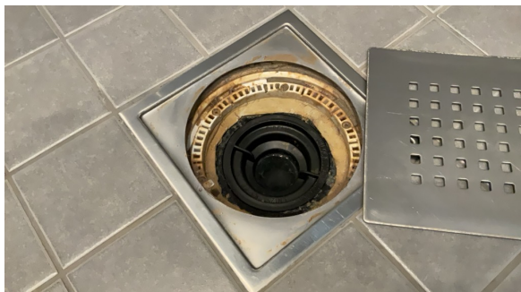
Kontroll av sluk.
