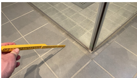
Liten bom/hullyd på 2 fliser.
