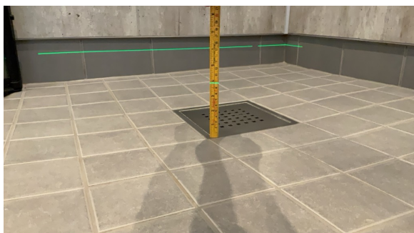
Målt fall til sluk: 46mm
