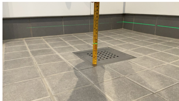
Målt fall til sluk: 25mm
