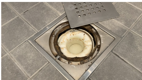
Kontroll av sluk.
