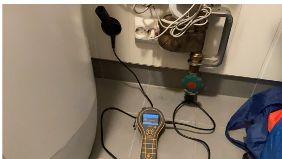
Hulltaking utført fra tilstøtende rom.
