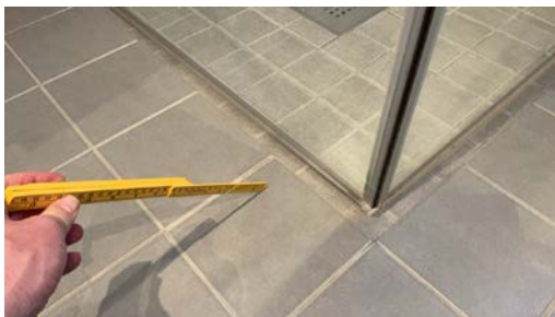
Liten bom/hulldyd på 2 fliser.
