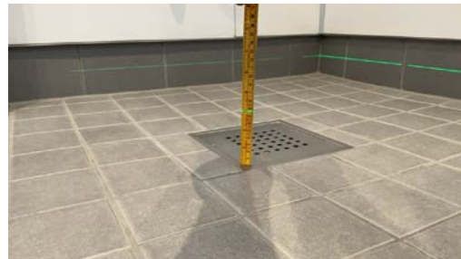
Målt fall til sluk: 25mm
