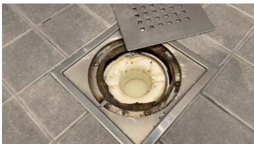
Kontroll av sluk.
