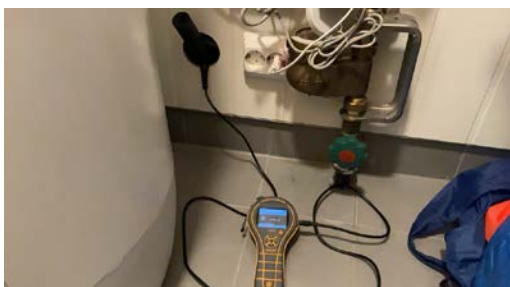
Hulltaking utført fra tilstøtende rom.
