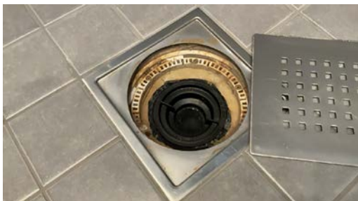
Kontroll av sluk.
