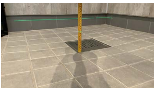
Målt fall til sluk: 46mm
