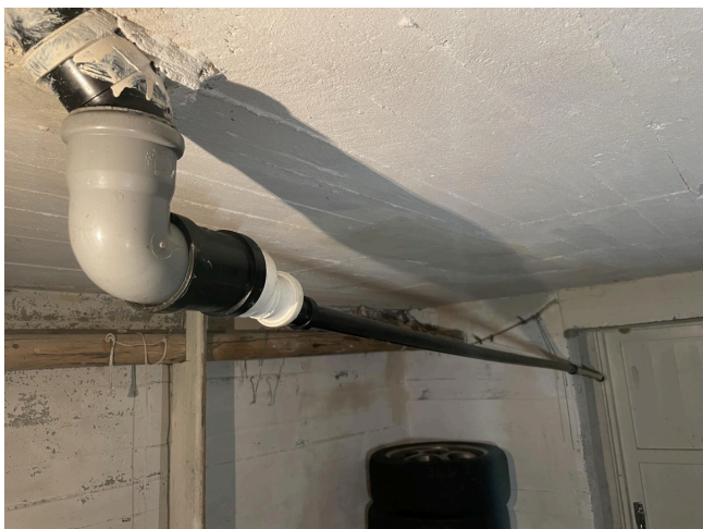
Uisolert avløpsrør i uoppvarmet rom.
