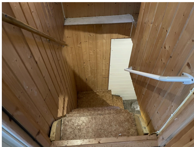
Trapp fra hovedetasje til kjelleretasje.
