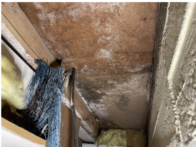
Store fuktskader.
