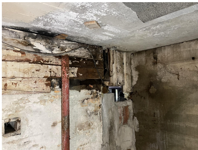
Store fuktskader.
