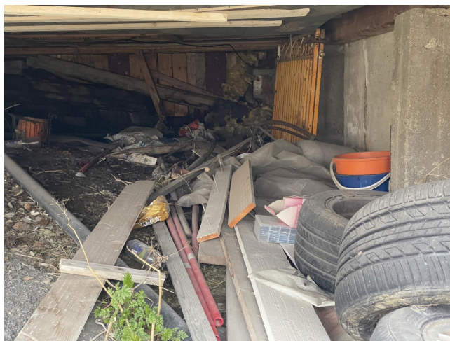
Manglende terrengfall vegg fra bygningen.
