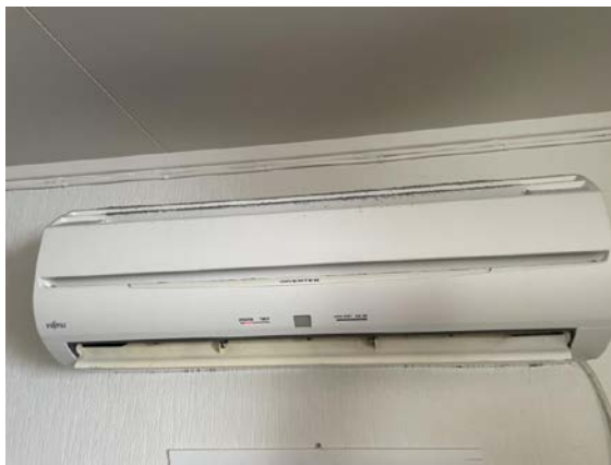
Produktet nærmer seg utløpsdato (forventet levetid: 12–15 år med service).
