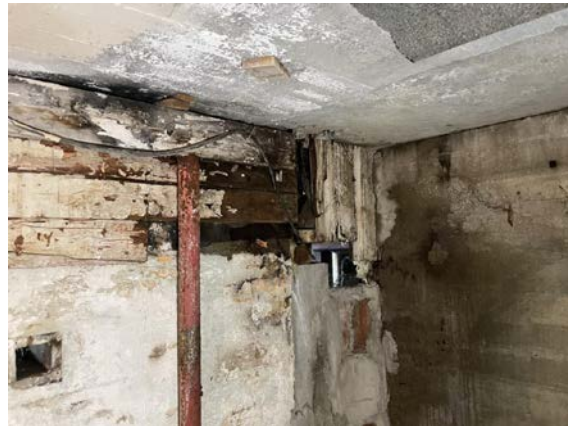
Store fuktskader.
