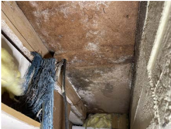
Store fuktskader.
