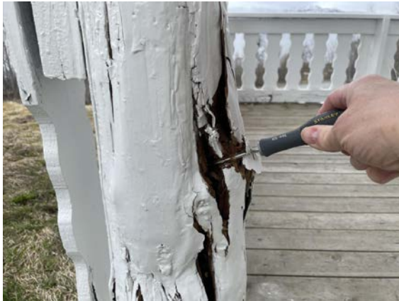
Store synlige skader i bærekonstruksjonen.
