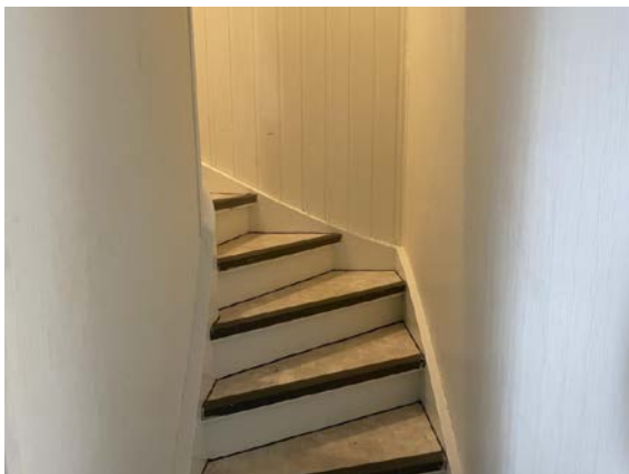
Trapp fra hovedetasje til loft.
