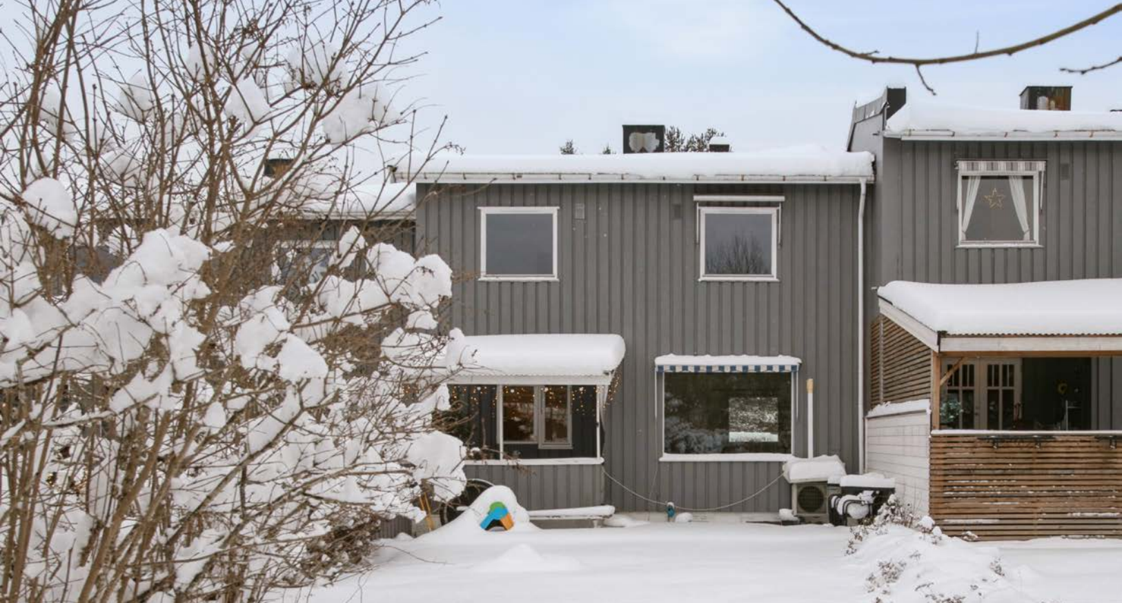
Utvendig fikk rekkehusene ny drenering i 2018 og ny takpapp i 2010.
