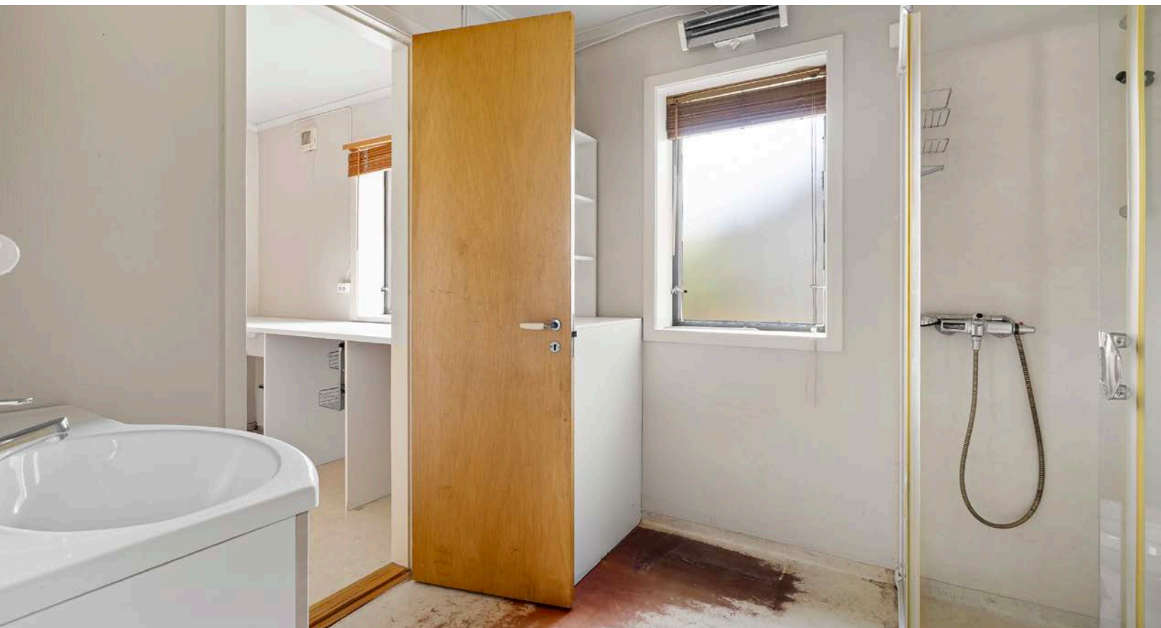
Badet er innredet med toalett, servant, dusjkabinett og varmtvannsbereder.
