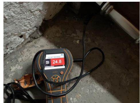
Fuktmåling i nedre del av trapp.
