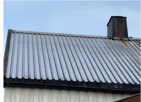
Tak tekket med stålplater.
