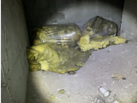
Krypkjeller under tilbygg.
