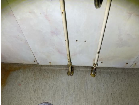
Veggplater/membran punktert med skruer.
