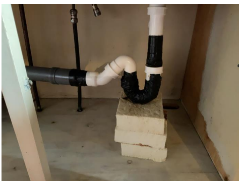
Oppstøtting av avløpsrør i benkeskap.
