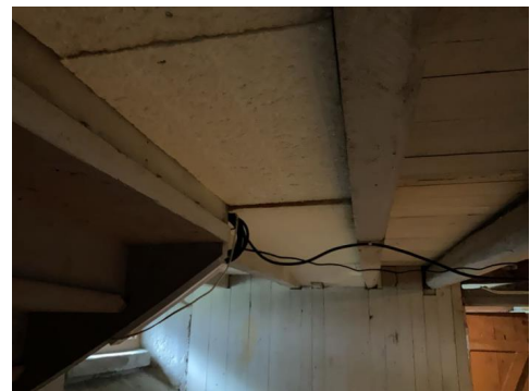
Påbegynt isolering med isolerende plater.
