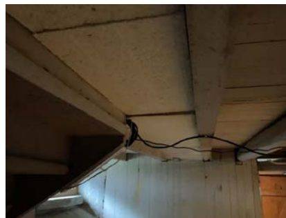
Påbegynt isolering med isolerende plater.
