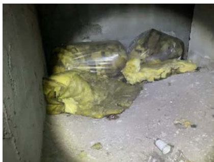
Krypjkjeller under tilbygg.
