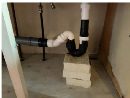
Oppstøtting av avløpsrør i benkeskap.
