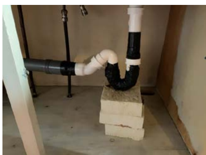
Oppstøtting av avløpsrør i benkeskap.
