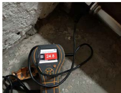
Fuktmåling i nedre del av trapp.
