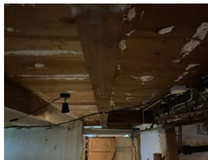
Etasjeskille i 1. etasje er delvis isolert.
