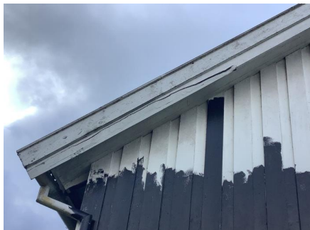
Råteskadet vindski.
