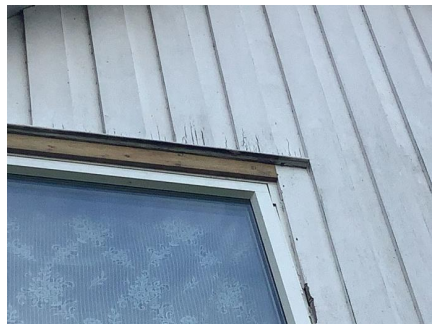
Råteskadet bordkledning.
