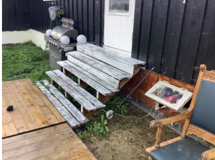
Manglende rekkverk.
