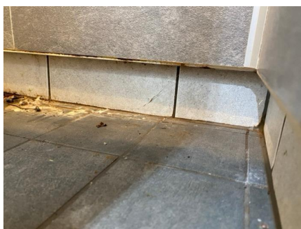
Baderomsplate er montert utenfor sokkellist.
