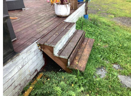
Manglende rekkverk.
