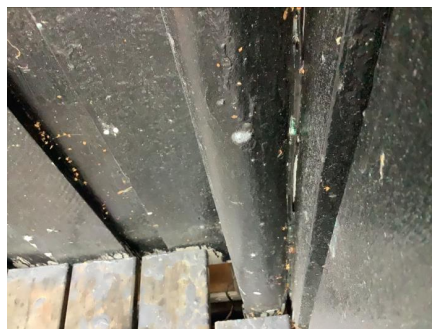
Frostsprengt nedløpsrør.
