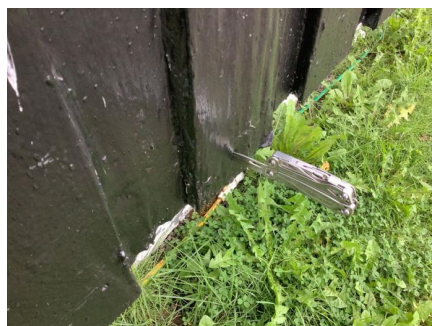
Råteskadet bordkledning.
