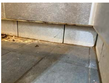
Baderomsplate er montert utenfor sokkellist.
