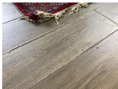
Svellskadet laminatgulv.
