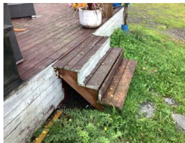
Manglende rekkverk.
