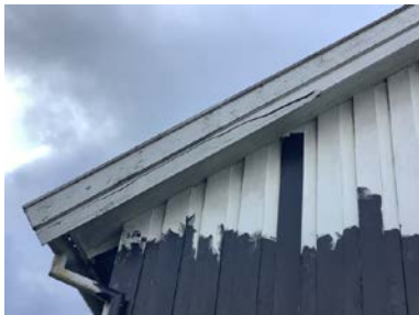
Råteskadet vindski.
