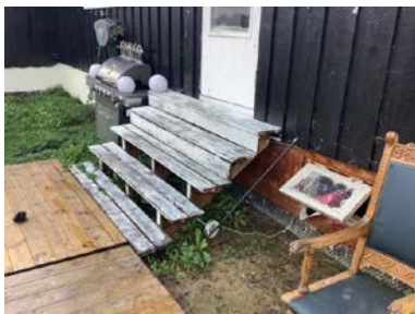
Manglende rekkverk.
