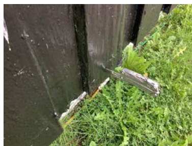
Overmalte råteskader.
