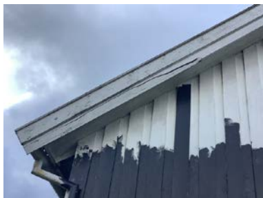
Råteskadet vindski.
