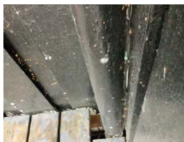
Frostsprengt nedløpsrør.
