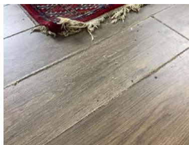
Svellskadet laminatgulv.
