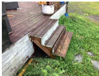
Manglende rekkverk.
