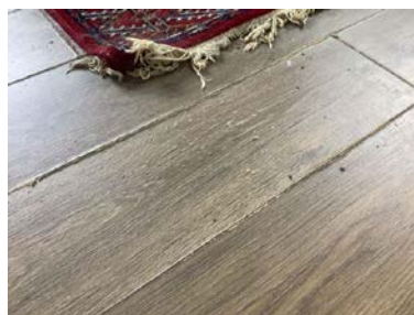
Svellskadet laminatgulv.
