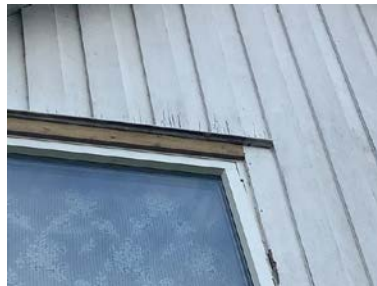
Råteskadet bordkledning.
