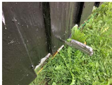
Overmalte råteskader.
