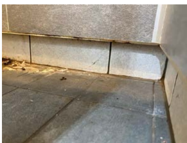
Baderomsplate er montert utenfor sokkellist.
