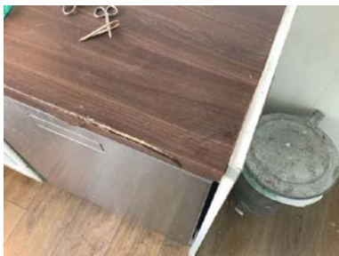
Skadet benkeplate og svellskadet dekkside.
