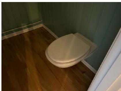
Manglende drenering. Ikke ventilasjon fra rommet.
