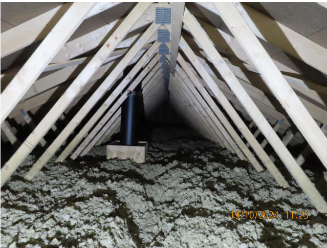
Takkonstruksjon, isolasjon og pipegjennom loftet.
