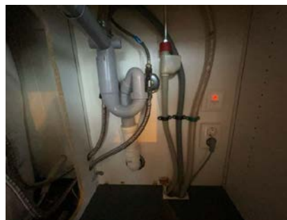
Synlige rør under kjøkkenbenken.
