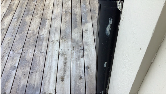
Frostsprenget nedløpsrør.
