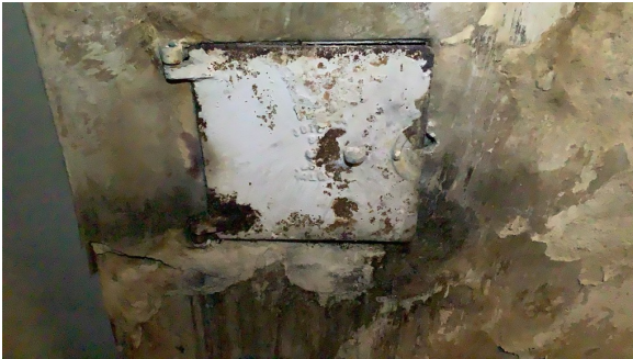
Skadet sotluke.
