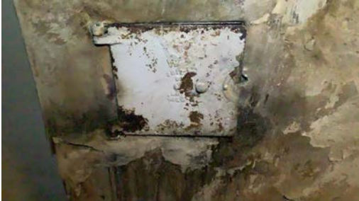
Skadet sotluke.
