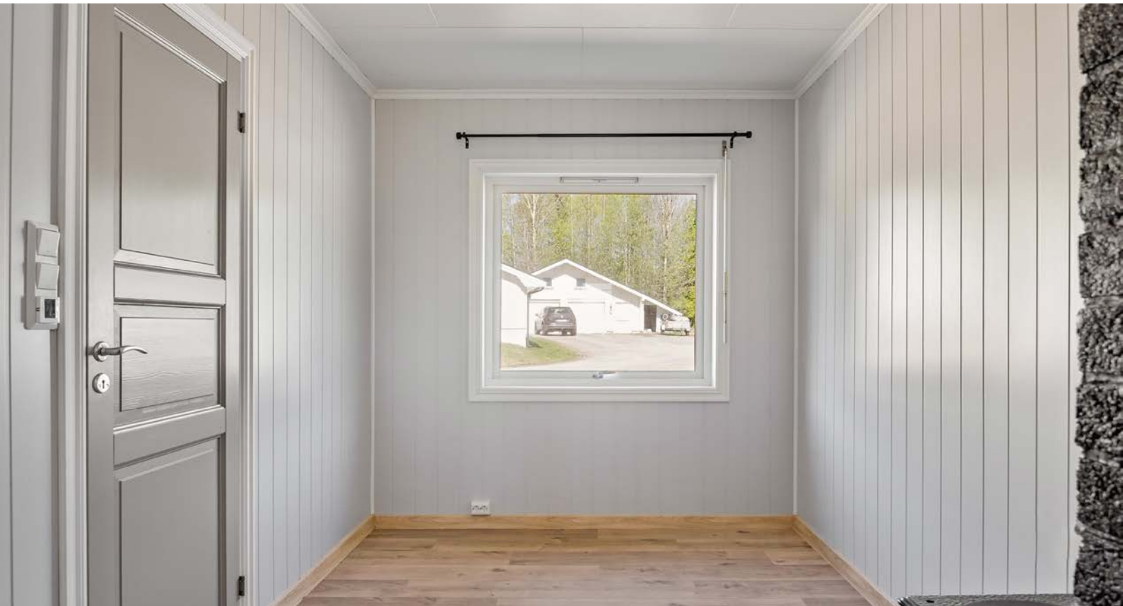
Gulv med laminat og vegger med malte plater.
