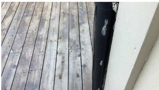
Frostsprengt nedløpsrør.
