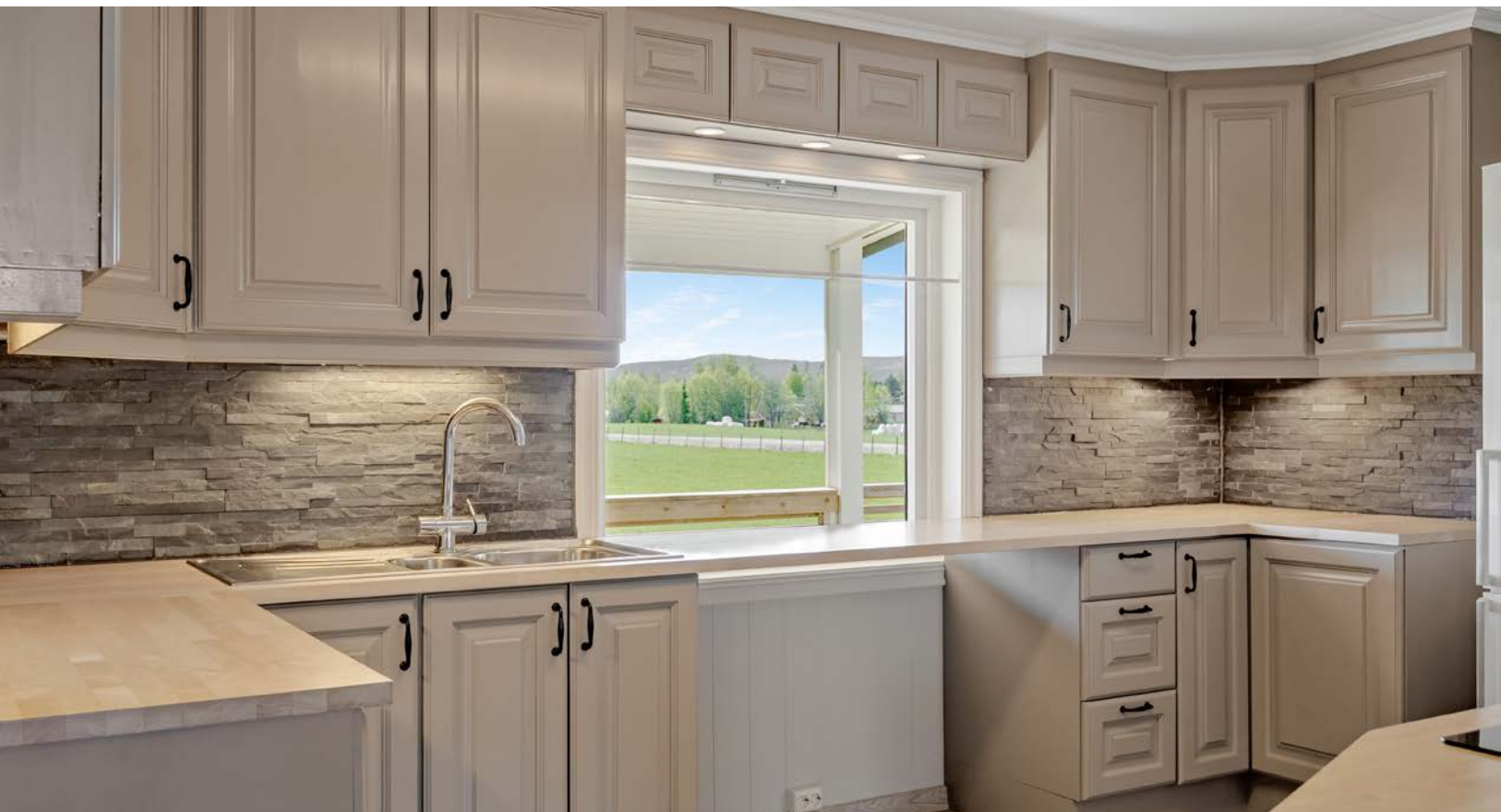
Det er laminat benkeplate med nedfelt rustfri servant med sidefelt. Benkeryggen er flislagt.
