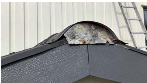
Endelukk av fuktskadet treverk.
