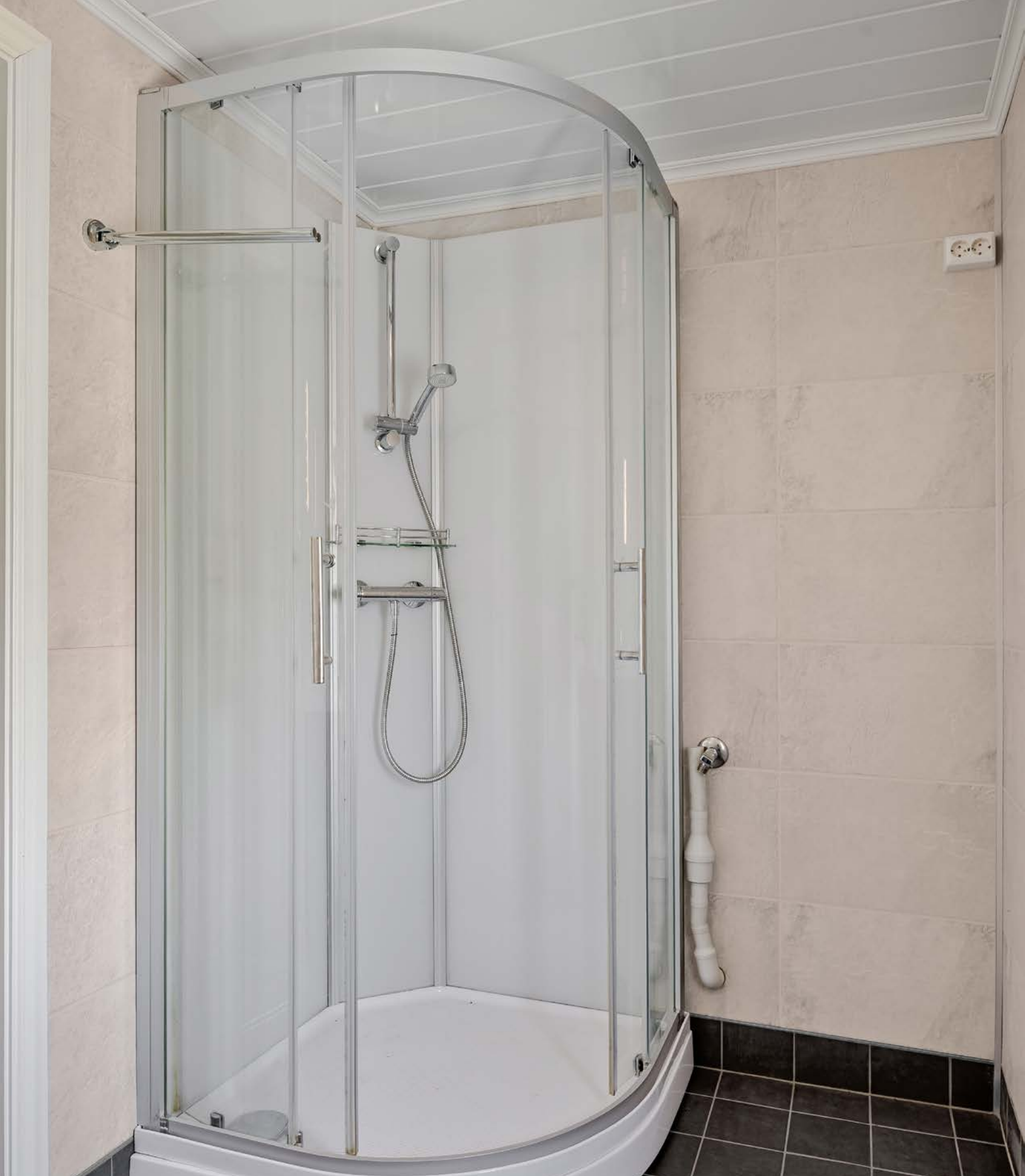
Her er det dusjkabinett og opplegg for vaskemaskin.
