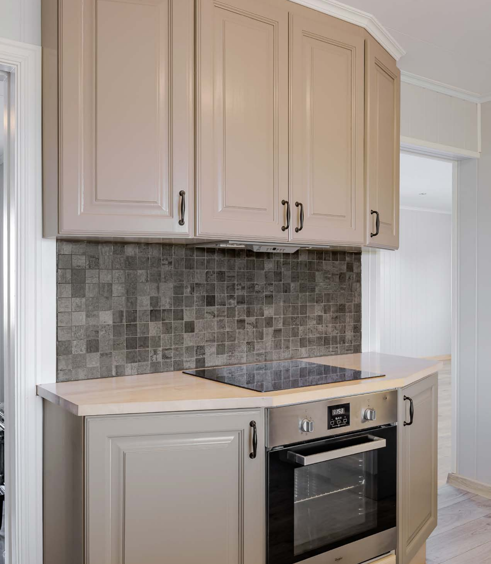
Det er kjøkkenventilator med avtrekk ut i pipens lufteløp.
