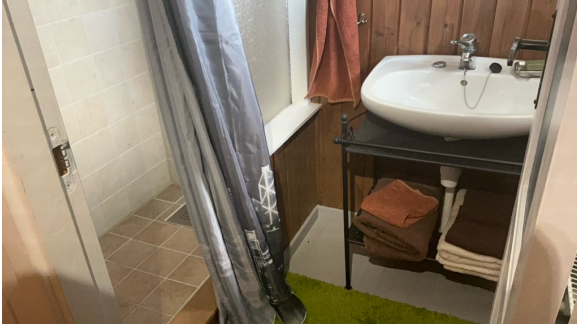
Oversiktsbilde av bad.
