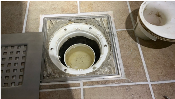
Kontroll av sluk.
