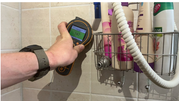
Enkle fuktsøk viste normale verdier.
