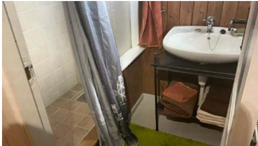
Overtsiktsbilde av bad.
