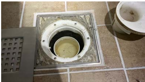
Kontroll av sluk.
