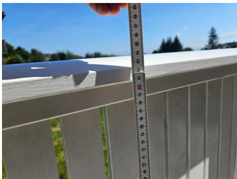
Rekkverk er målt til ca.84cm.
