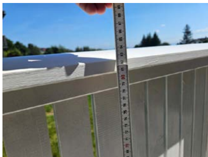
Rekkverk er målt til ca.84cm.
