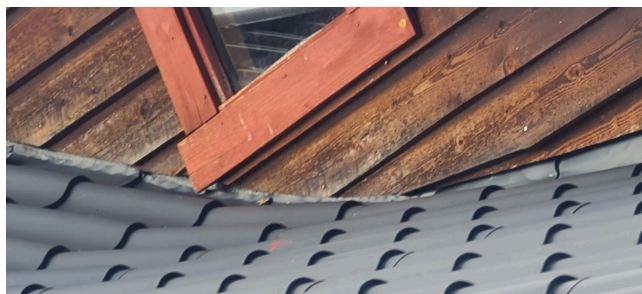
Overgang takplater/kledning på vegg.
