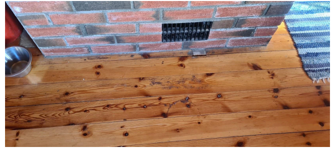
Gulv i passasje fra stue til kjøkken.
