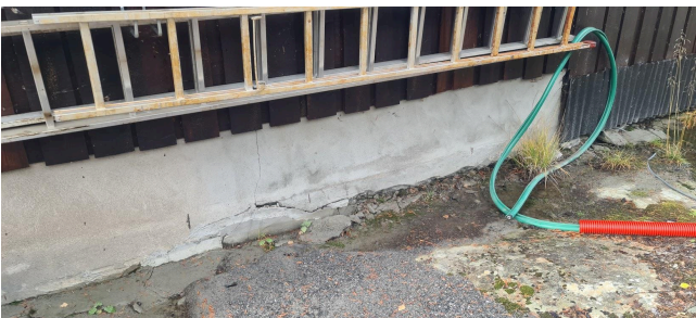
Sprek og deformasjon på grunn ut for gang; årsak kan være kombinasjon vann som fryser og telehiv.
