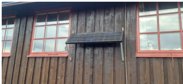
Solcellepanel som antas til bruk for belysning.
