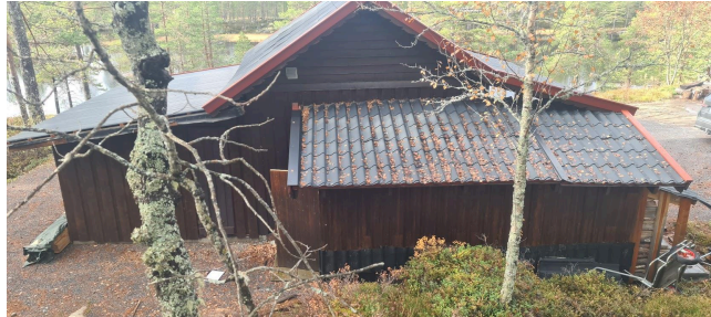
På baksiden av uthus hvor agregatrom er plassert.
