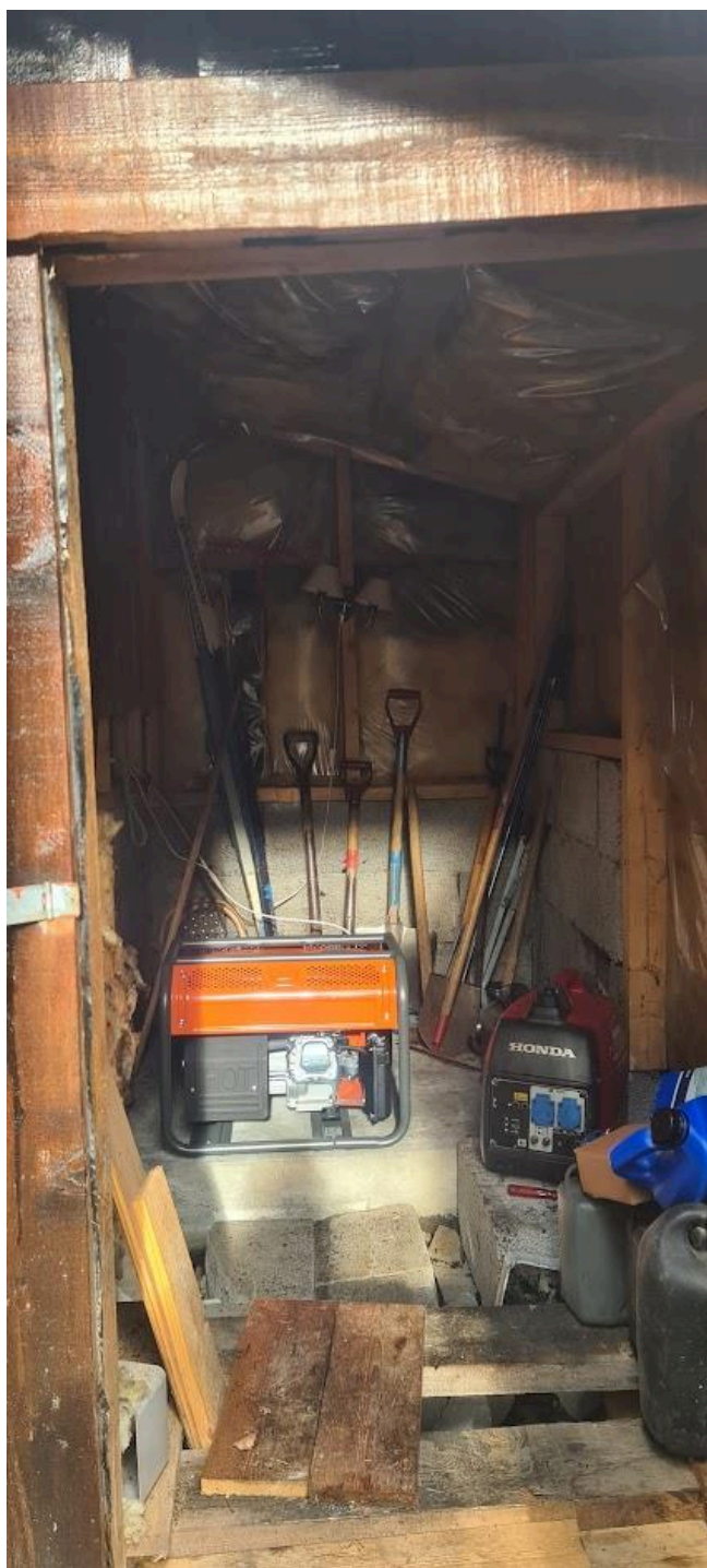
Rom hvor strømagregat er plassert.
