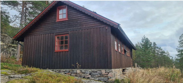
Murt grunnmur av gråstein med betoongmørtel mellom.
