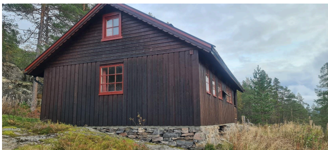
Tømmermannskledning med liggende kledning i topp gavli.
