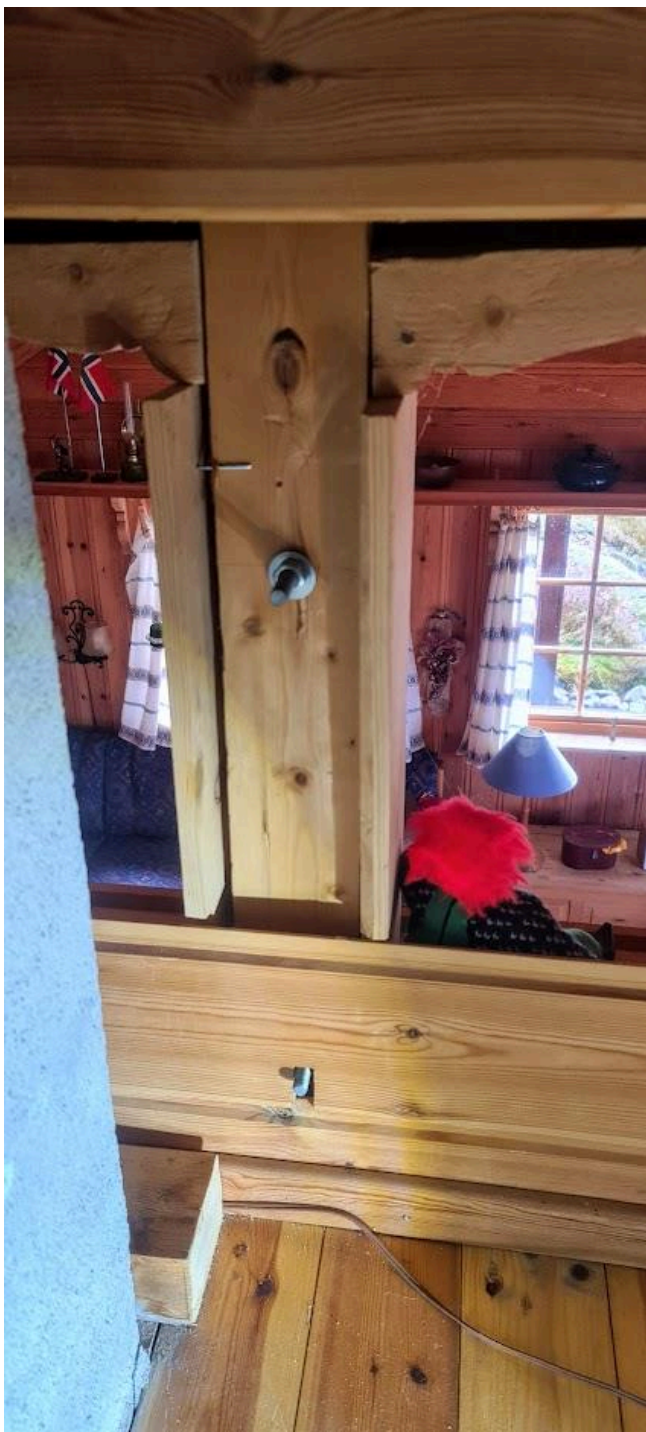
Stolper med gjennomgående bolter mellom åpninger ned mot stue .
