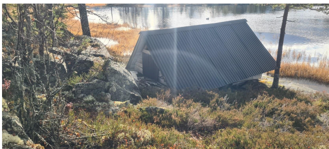
Båthus med takplater delvis ned til terreng på langvegger.
