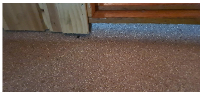
Terrazzo montert på sokkel under panel.
