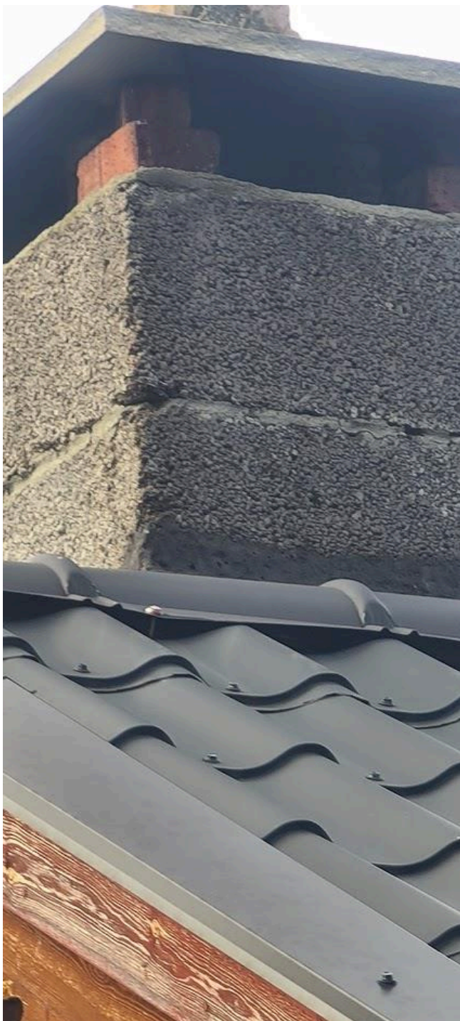
Elementpipe over tak.
